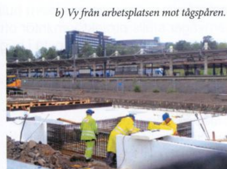
Figur 3. Flemingsbergs station med fem spår. Spåren är grundlagda på en ca 3 m hög bank på lera. Byggarbetena för lägenhetshotellet som ligger närmast spåret, hade påbörjats.
